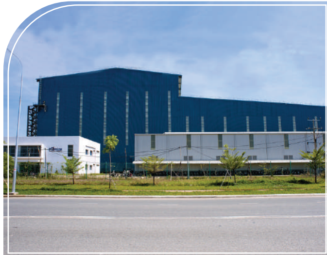
NHÀ MÁY THÉP POMIA KCN Phú Mỹ 3, Tỉnh Bà Rịa Vũng Tàu
